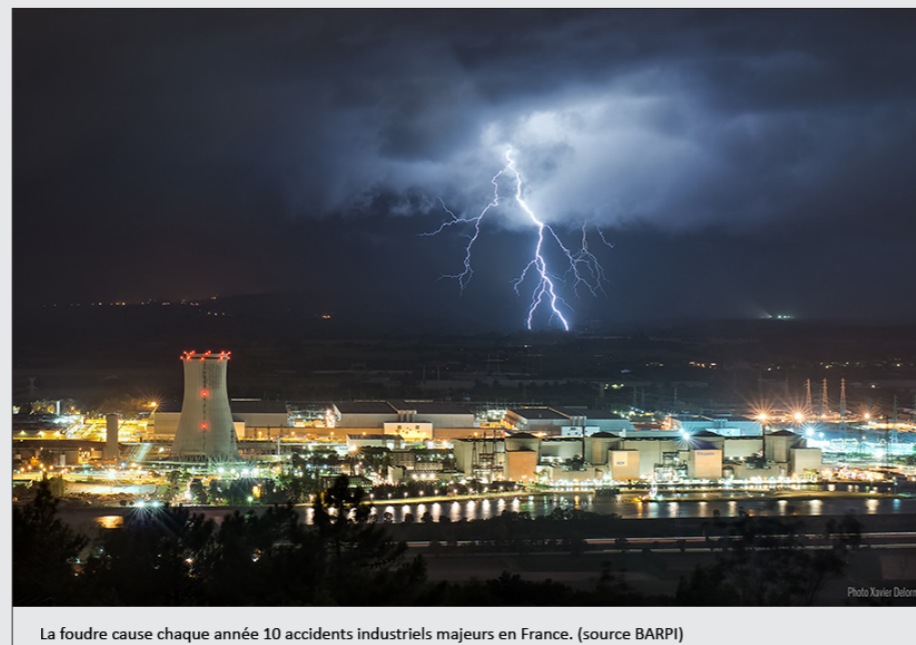
La foudre cause chaque année 10 accidents industriels majeurs en France. (source BARPI)
